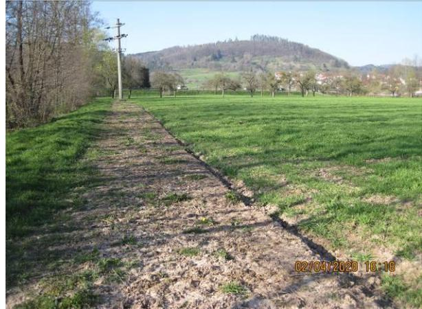
Abb. 10: Freileitungsmast mit unterirdisch verlegter Stromleitung
